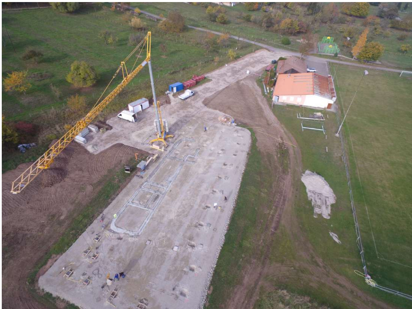
VUE AERIENNE DU CHANTIER DE LA SALLE COMMUNALE
